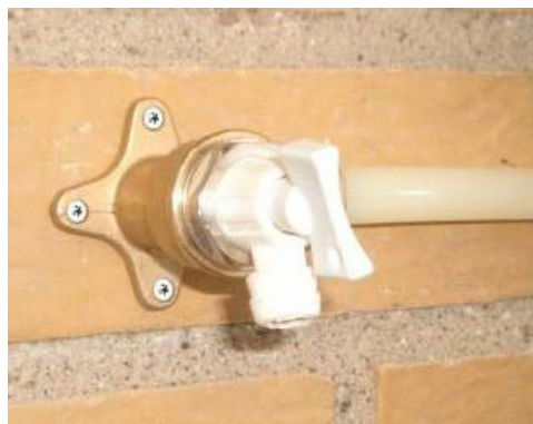
Udluftningshane for akkumuleringskammer (kun model Single og Combi)
